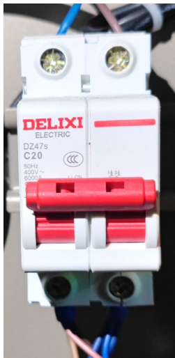
图4-3 空开接线示意图
