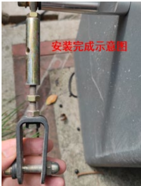
图3-11 栅栏闸杆主杆安装
