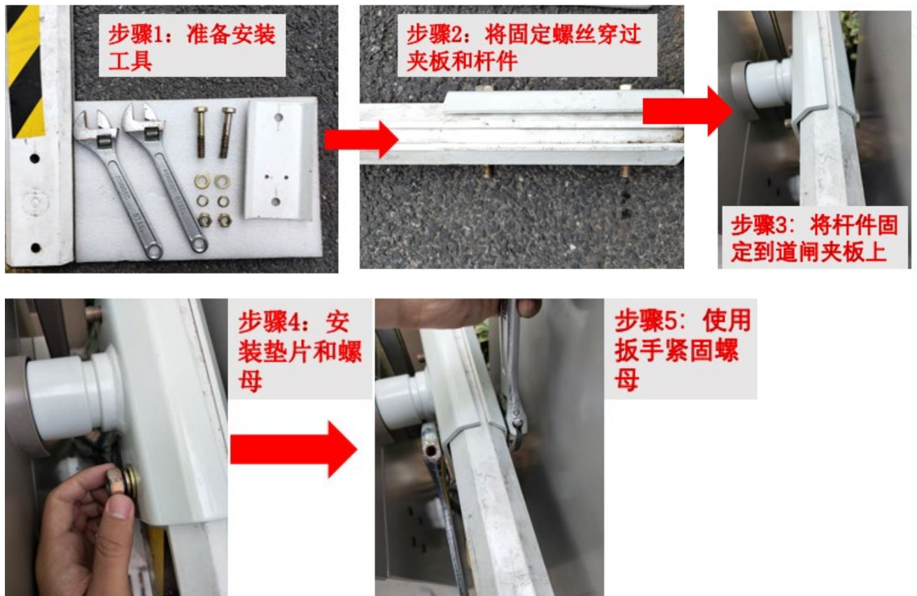
图3-5 曲臂杆主杆安装步骤
