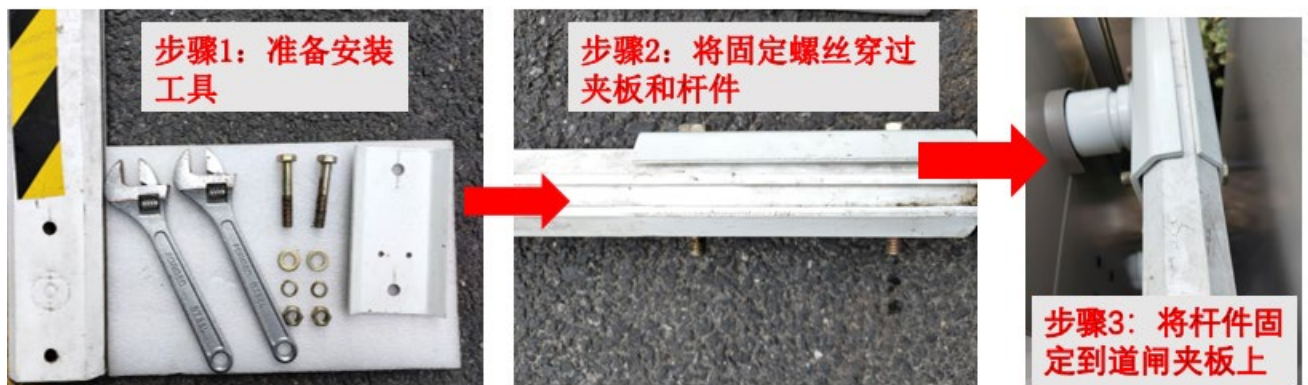
图3-4 直杆带胶条闸杆安装
