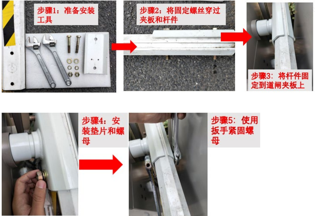
图3-18 伸缩杆闸杆安装图片
