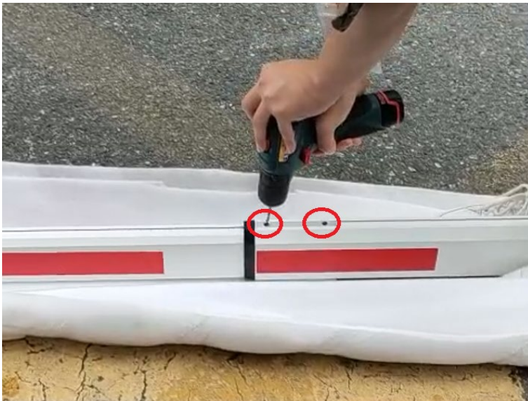
图2-6 杆件打孔示意图
