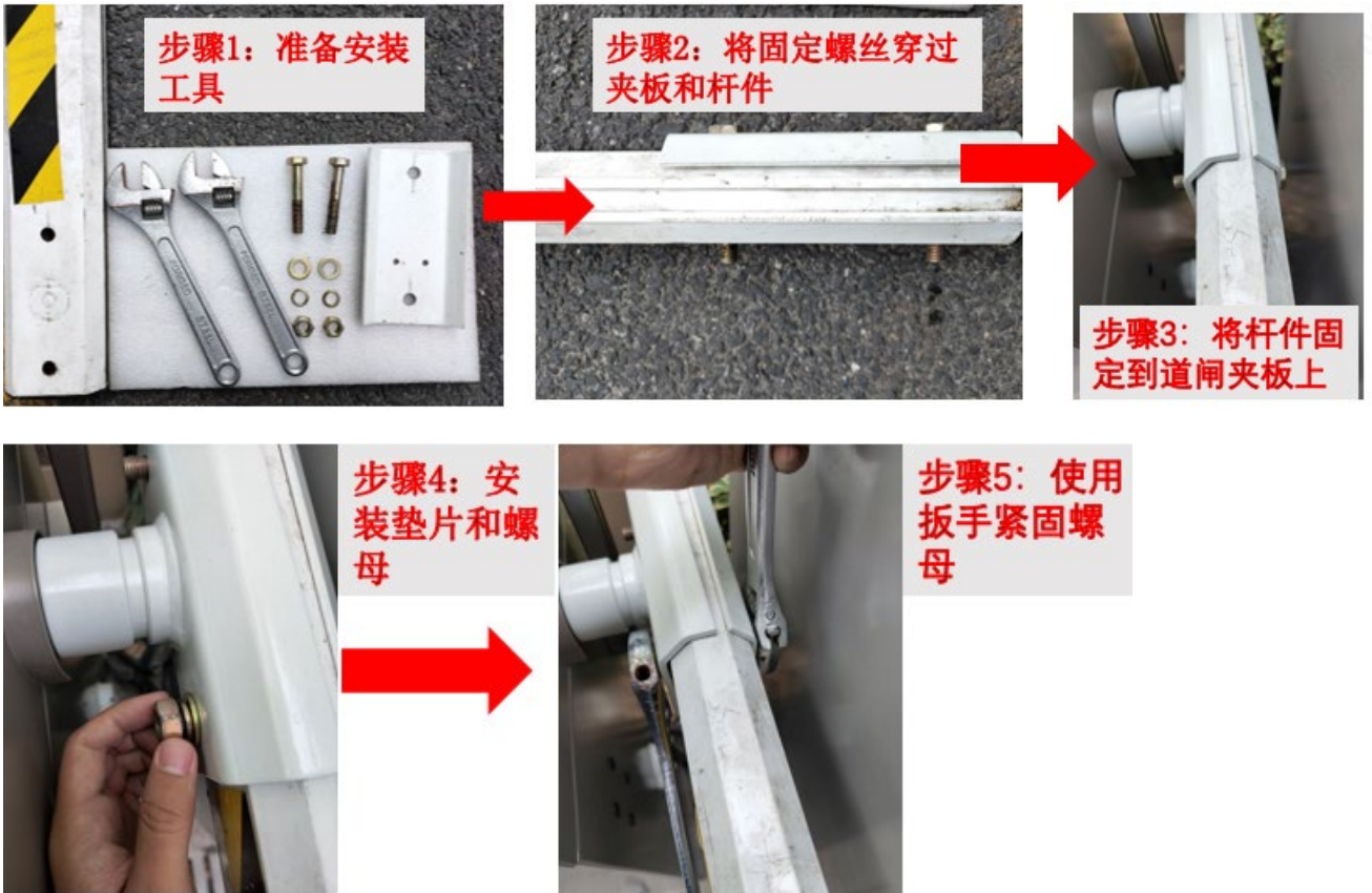
图3-8 曲臂杆主杆安装步骤
