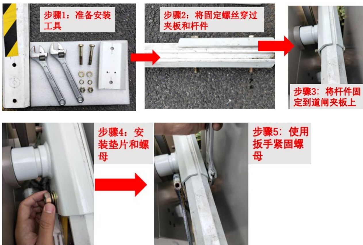
图3-4 直杆带胶条闸杆安装
