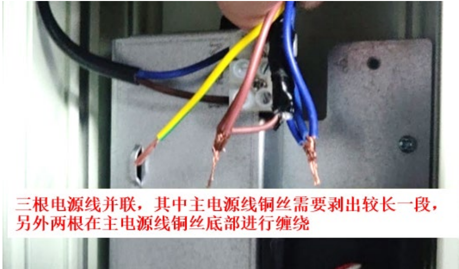
图2-3 电源线路接线 2/2
