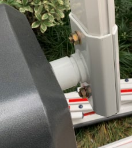
图3-35 伸缩杆闸杆安装图片
