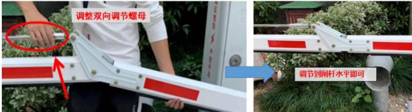
图3-26 曲臂杆平衡调节步骤
