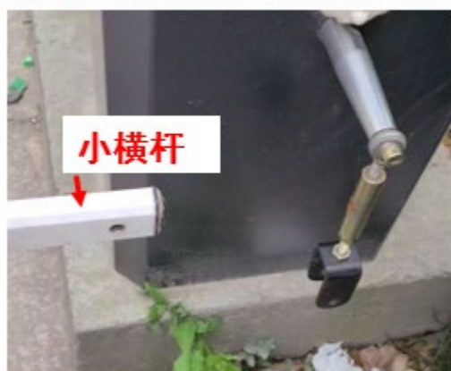
步骤1: 对齐杆件夹板和螺丝孔
