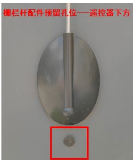
图3-29 栅栏杆安装配件 PK-PJ-ZL-ZD 示意图
