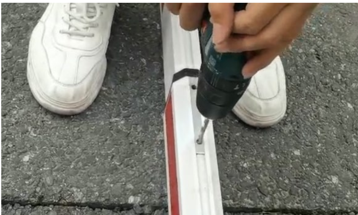
图3-33 杆件打孔示意图
