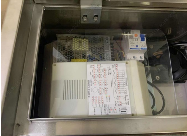
图6-7 防水塑料板安装
